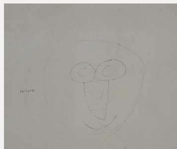
Tag sur le mur du bâtiment annexe de la Mairie (ancien cycle 3)
