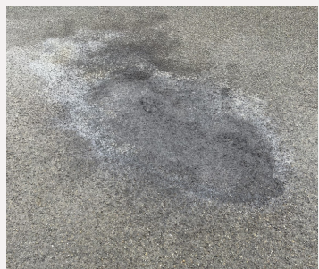
Vidange d'une voiture par un particulier sur le parking derrière la salle des fêtes.
